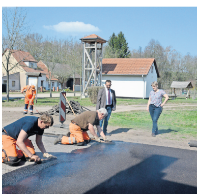
Die Mitarbeiter von BAB Asphaltbau Ziesar haben die Sanierung der Straße zügig erledigt. FOTO: MARGRIT HAHN
